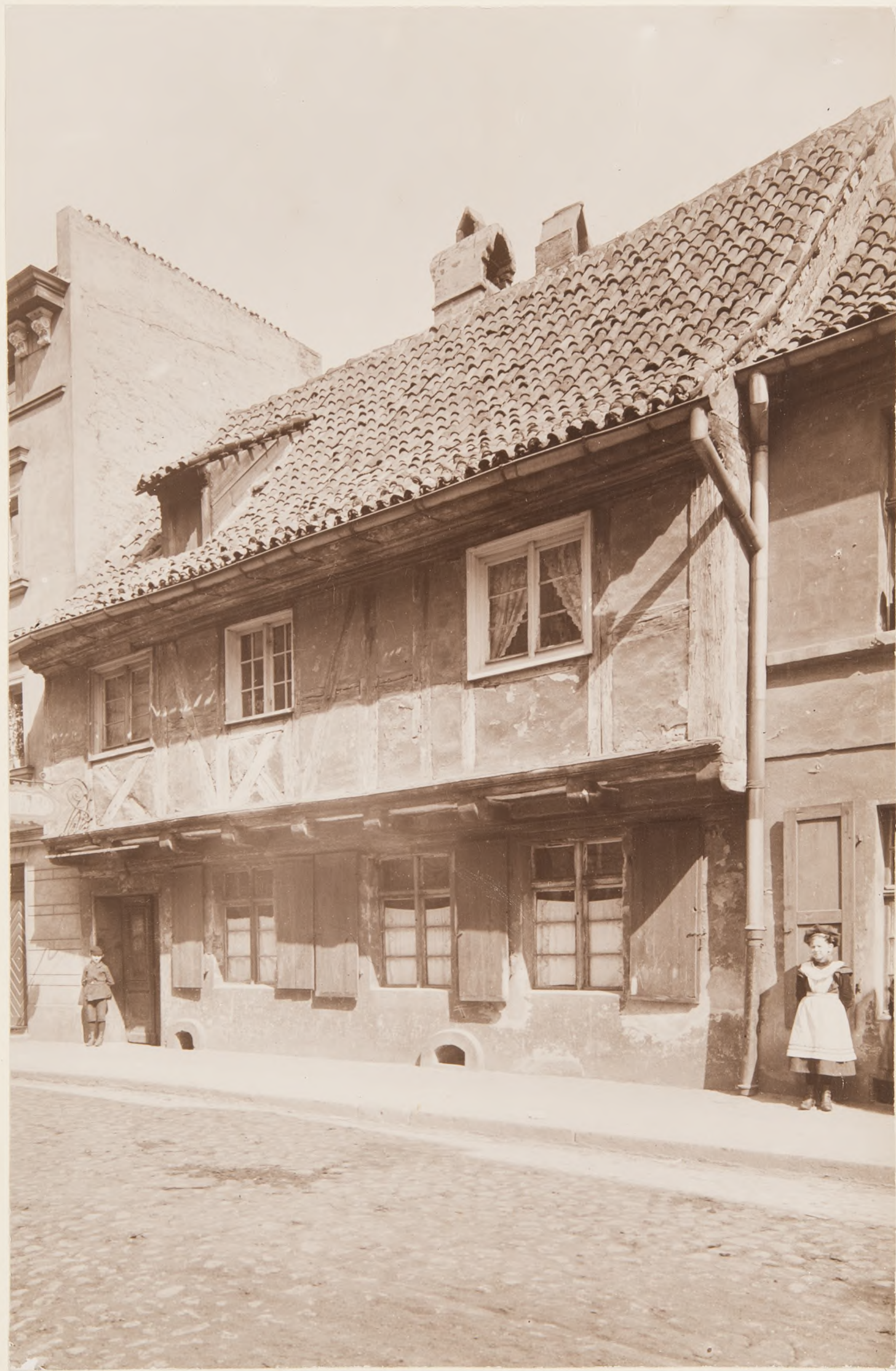
Thorn Mauerstrasse 64. Fachwerkhaus.
