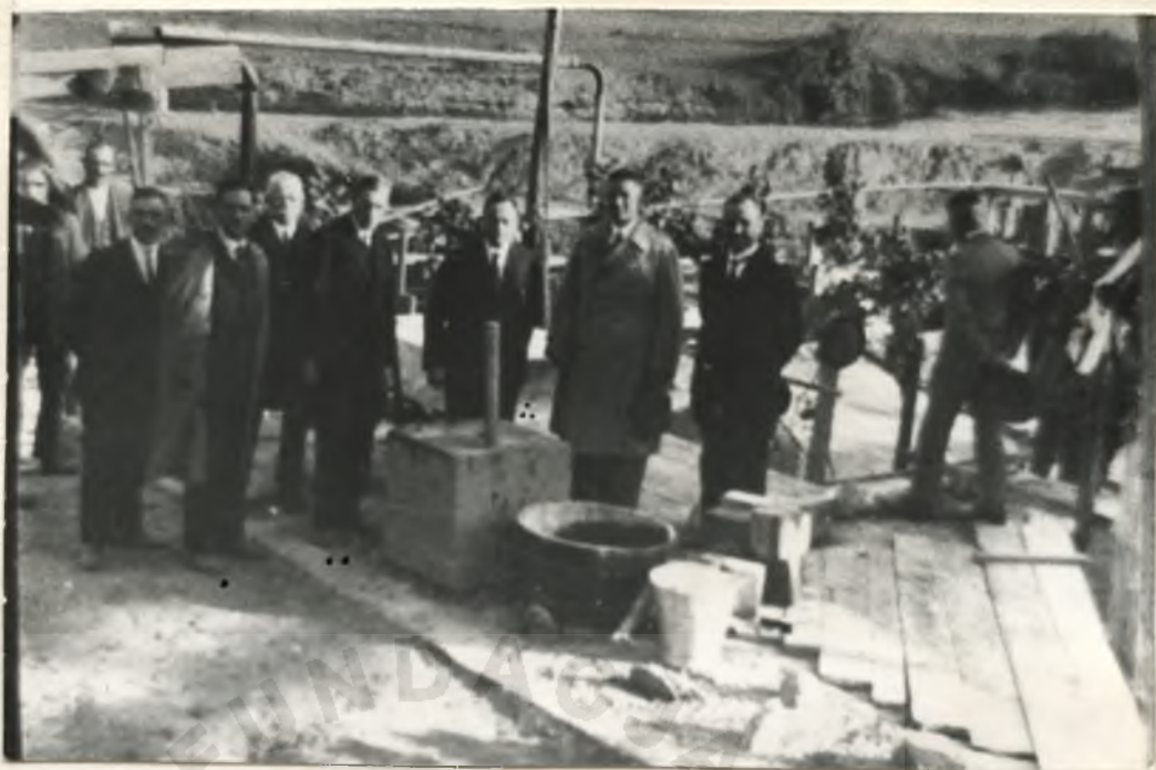
WMUROWANIE KAMIENIA WĘGIELNEGO POD ELEKTROWNIĘ WRATOWĄ „GRÓDEK” 26.08.1929r. • OTCIEC; WOJEWODA POM. LAMOT, • INZ. HOFMANN
