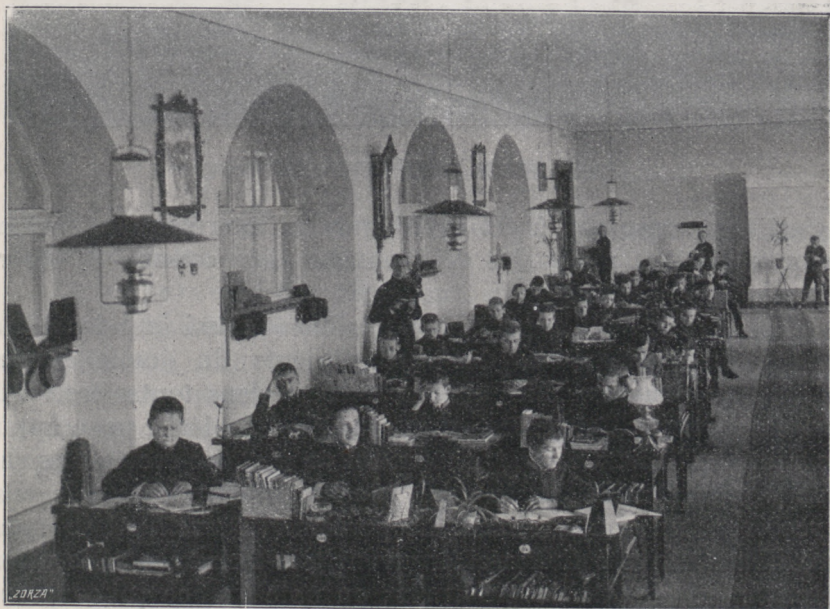
Salle d'étude, Lycée-internat à Chyrów.
