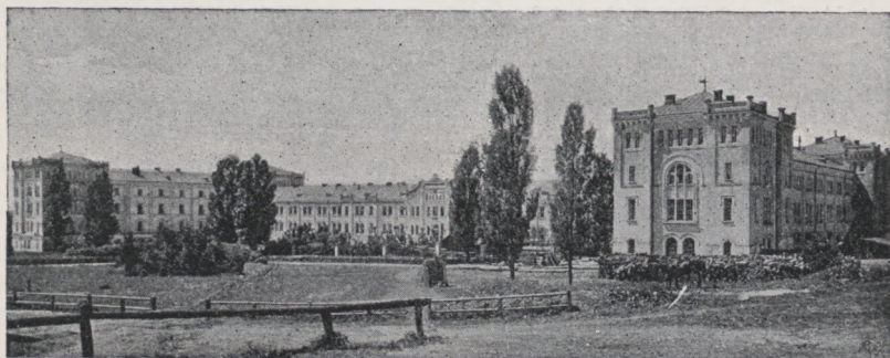
Orphelinat de l'Institut Skarbek, Drohowyże. Vue d'ensemble.
