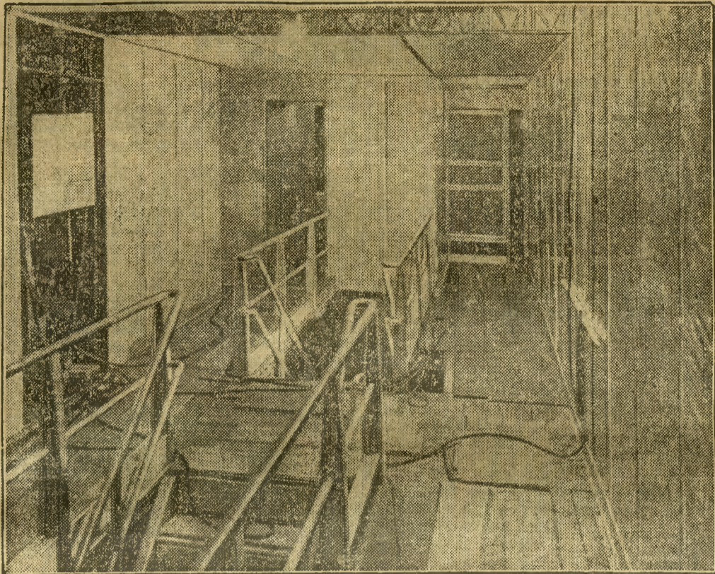
W nowym olbrzymim sterowcu „LZ 129” budowanym obecnie we Friedrichshafen sale i kabiny pasażerskie mieścić się będą w dwóch kondygnacjach. — Pierwsza podróż próbna tego olbrzymia o długości 280 m. a wysokości 41,2 ma się odbyć w najbliższym czasie
