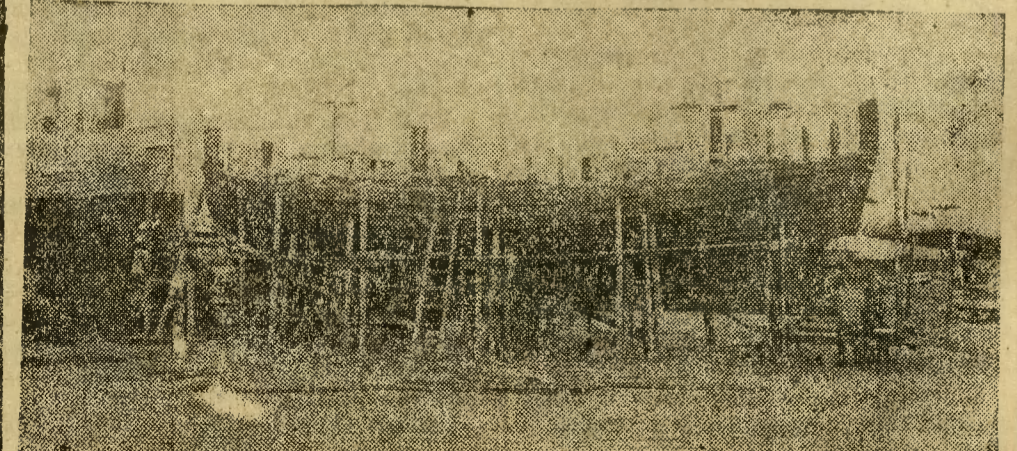
Kutr rybacki w budowie.
