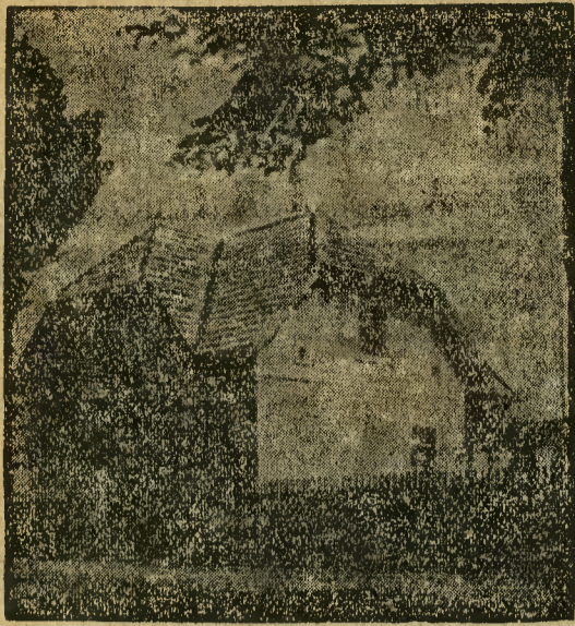
Nowa budowa naszego członka właśc. domu p. Piotra Kamińskiego, Tczew, Wybickiego 27, pożyczka 8.000,—
