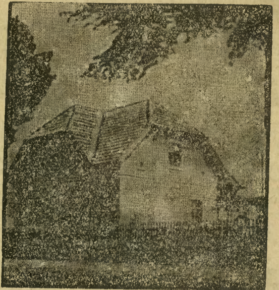
Nowa budowa naszego członka p. dyr. C. Kreczego Poznań, ul. Marsz. Focha 188a, pożyczka zł 14.000.—
