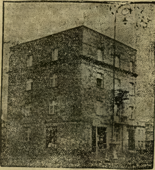
Nowa budowa naszego członka właśc. domu p. Piotra Kamińskiego, Tczew, Wybickiego 27, poz. zł 8.000,—
