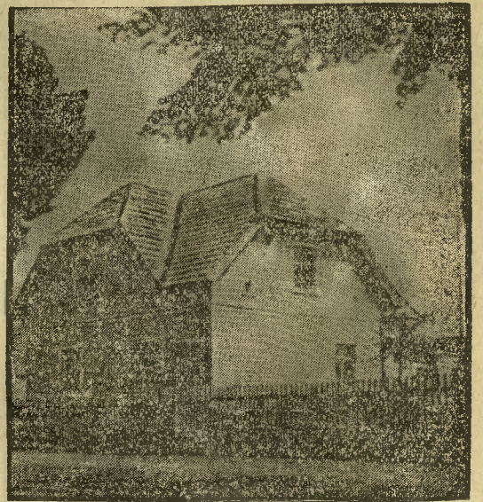
Nowa budowa naszego członka p. dyr. C. Kreczego Poznań, ul. Marsz. Focha 188a, pożyczka 14.000,—
