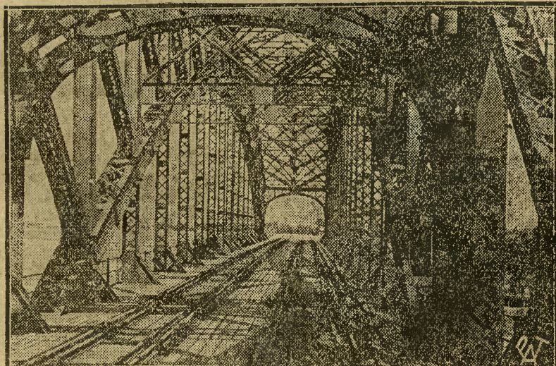
Most na Wiśle, zbudowany specjalnie dla warszawskiej linii średnicowej, której uroczyste otwarcie nastąpi dn. 2 września. Do budowy tego mostu zużyto 5.000 ton żelaza. Powierzchnia muru wynosi 22.000m 2 .
