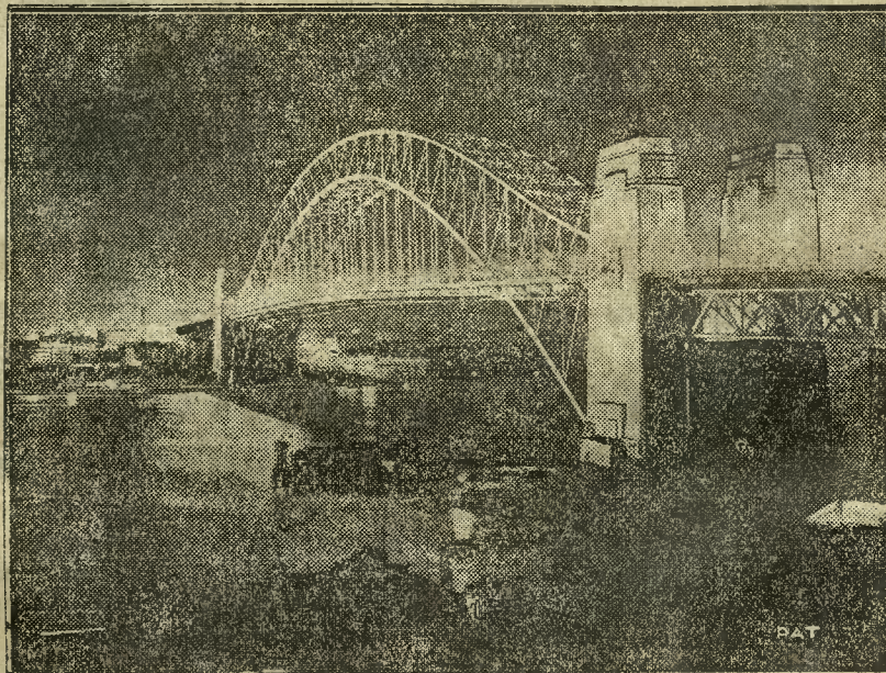
Na zdjęciu naszym widzimy jeden z najpiękniejszych i najsmielszych w konstrukcji mostów żelaznych, który oddano niedawno do użytku. Jest to olbrzymi most w Australji, łączący oba brzegi tamtejszej zatoki. W dniu otwarcia most ten oświetlony był rzeszście światłem reflektorów staków wojennych.
