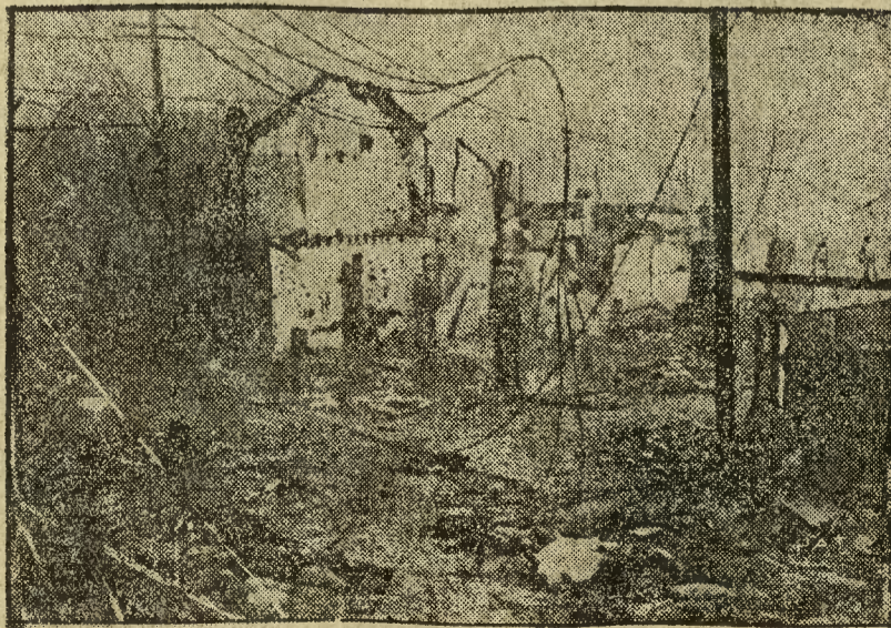
Ofiarą krwawych i zaciętych walk, toczących się od dłuższego już czasu między wojskami japońskimi w Szanghaju padła dzielnica chińska tego miasta, która uległa całkowitemu zniszczeniu. Na zdjęciu naszym widzimy fragment zniszczonego miasta, resztki murów — zniszczonych przewodów elektrycznych.
