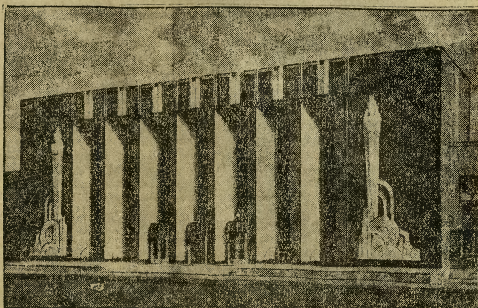
Prace przygotowawcze w Chicago do wielkiej wystawy światowej znajdują się w pełnym toku. Do jednych z najbardziej imponujących gmachów nowoczesnej architektury amerykańskiej należy gmach dyrekcji wystawy, który widzimy powyżej.
