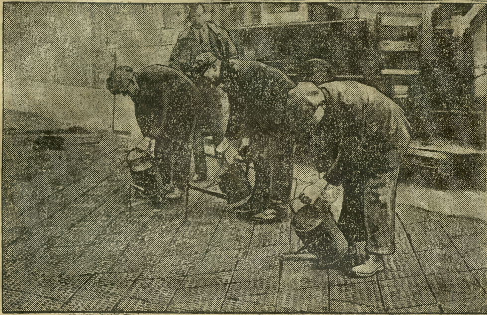
Ulice londyńskiego przedmieścia Islington zostały w drodze próby wyłożone płytami żelaznymi, które zastosowano zamiast asfaltu, niebezpiecznego wskutek swej śliskości. Powierzchnia płyt jest chropowata i rowkowana tak, iż nawet podczas dżdżystej pogody koła samochodowe znajdują na nich oparcie.
