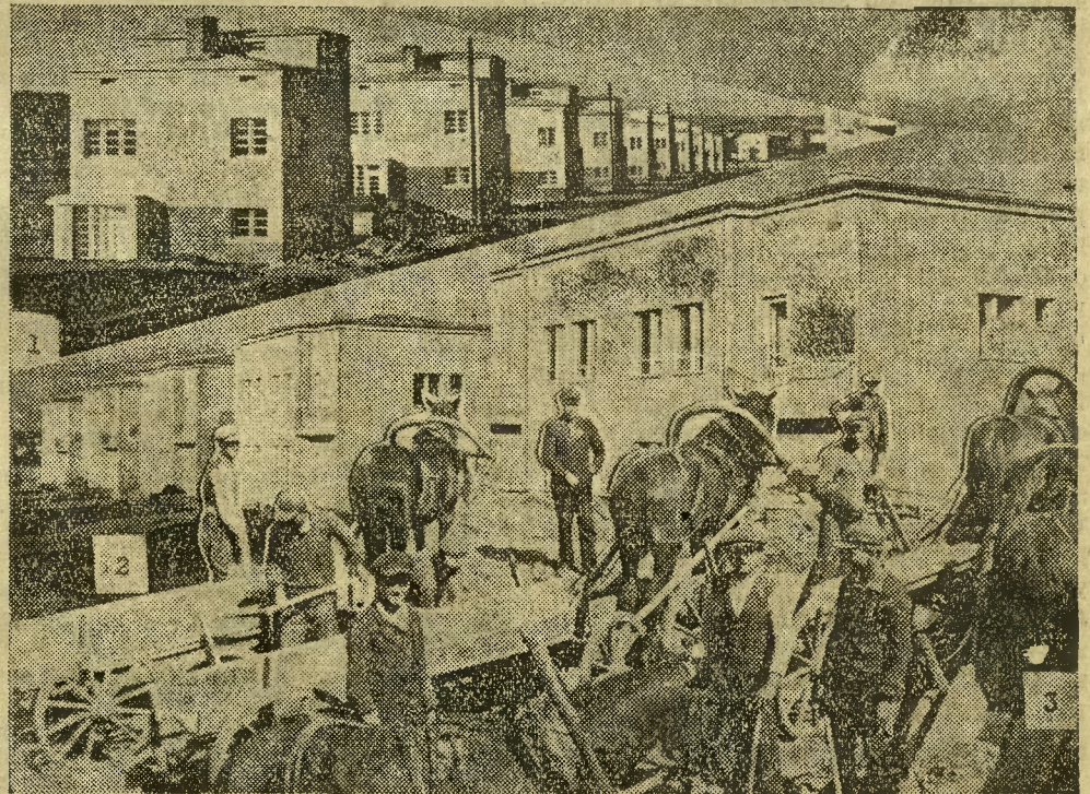
Furmanki z Kresów Wschodnich przybyły aż do Gdyni po zarobek, pracując przy nowych budowlach. Nowe osiedle na Redłowie wybudowane przez T. B. O.
