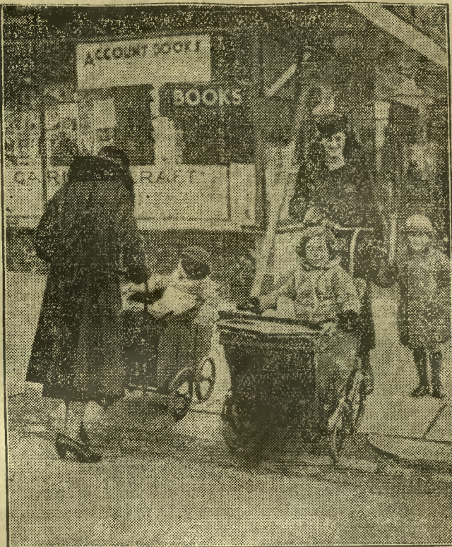
Na przedmieściu Londynu Friern Barnet wprowadzono specjalne udogodnienie dla matek, wożących swe pociechy w wózkach na spacer. Mianowicie na skrzyżowaniach ulic część prostopadych krawężników trotuarów zastąpiono płytami kamiennymi, tworzącymi łagodne pochylenie, przez które wózki dziecięce przejeżdżają bez żadnych wstrząsów.
