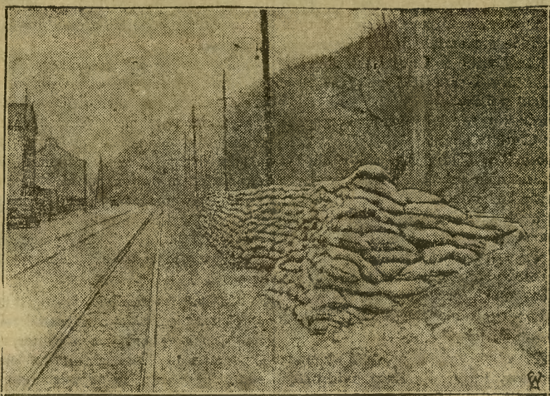
W pobliżu miejscowości Chatelet w Belgji zaczęło się niedawno obsuwać dość wysokie wzgórze, grożąc zasypaniem drogi wiodącej do tej miejscowości. Na zdjęciu naszym widzimy zapory, mające na celu zapobiec zasypianiu drogi przez obsuwające się zwaly ziemi.
