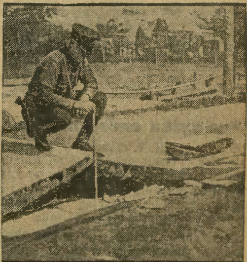
Fala upałów, która nawiedziła Stany Zjednoczone nie tylko spowodowała tysiączne ofiary w ludziach. W stanie Pensylwanja 42 stopniowe upały porozsadzały asfaltową nawierzchnię szos.
