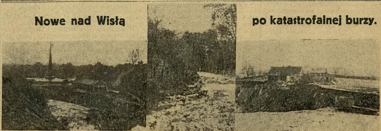
1) Cegielnia w Nowem zawalona ziemią, naniesioną spływającą wodą. Na przedzie głęboki parów. 2) Powyrywana droga w Nowem. 3) Dom dzierżawcy cegielni p. Ziętary, pozbawiony ścian frontowej i znajdujący się nad urwiskiem kilkunasotmetrowem.
