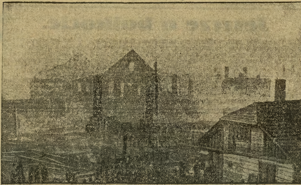
Miasto Zamość po groźnym pożarze, który 200 osób pozbawił dachu nad głową.
