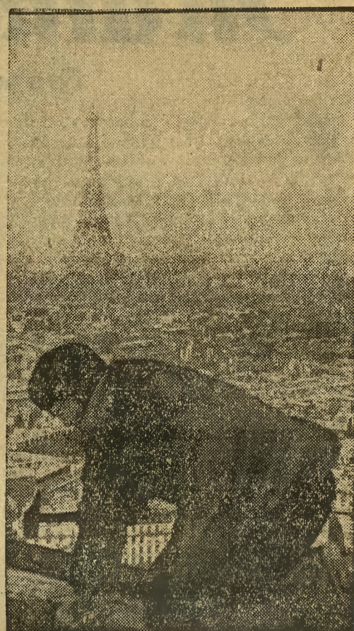
Robotnik pracuje na wysokości 100 m. nad poziomem ulicy paryskiej przy naprawie kopuły Domu Inwalidów.
