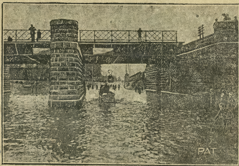
Skutki ostatniego deszczu w Warszawie.
