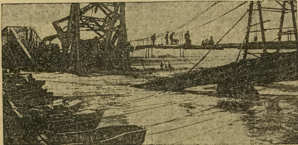
Fragment z prac przy odbudowie olbrzymiego mostu żelbetowego na rzece Żółtej w Chinach, zniszczonego całkowicie w wyniku działań wojennych chińsko-japońskich.
