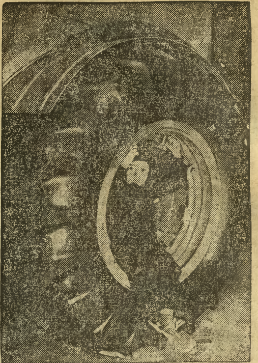
Nowym, podobno znakomitym, pomysłem amerykańskim jest wprowadzenie do walców, używanych do budowy dróg, kół obciążonych gumą zamiast kół żelaznych.
