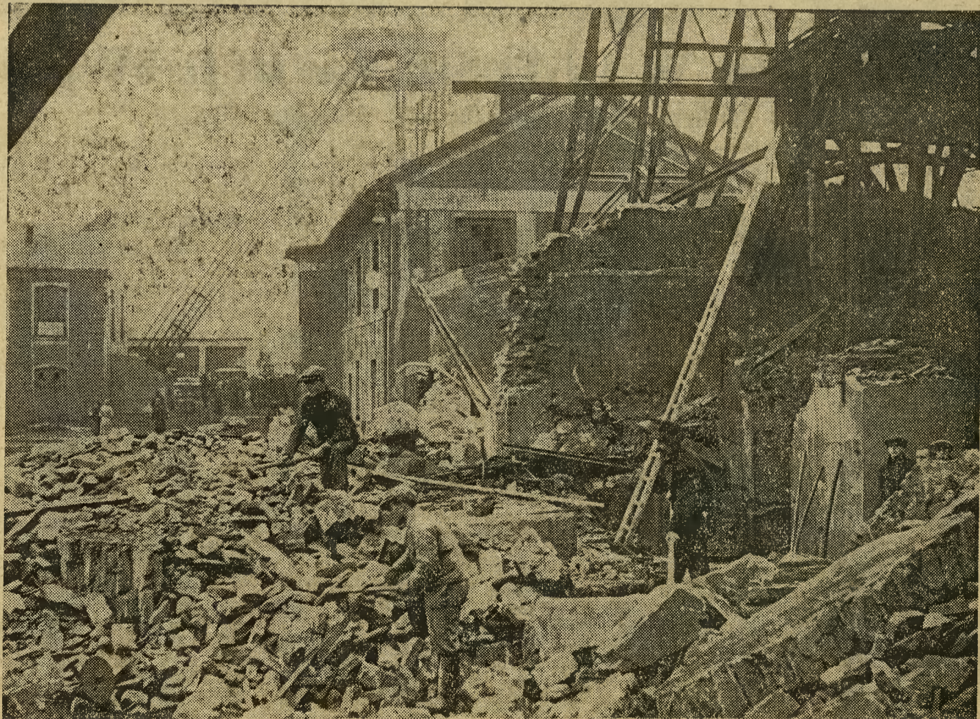
Uprzątnięcie gruzów po katastrofie w kopalni „Nelson III“.
