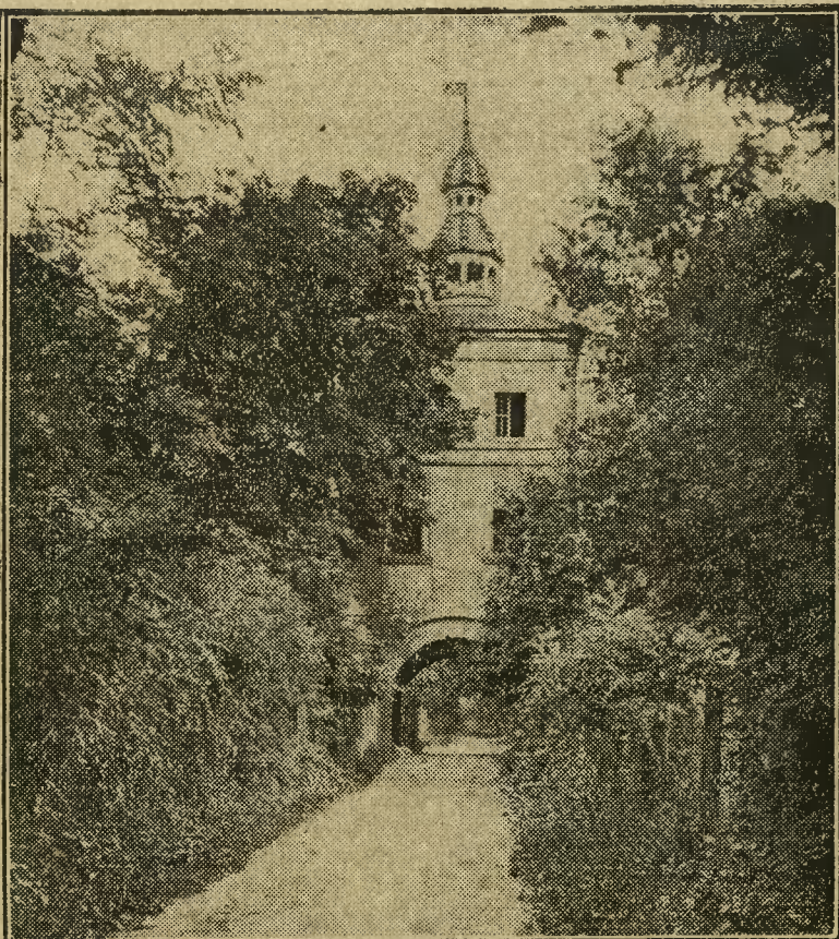
Baszta wjazdowa do zamku. Jedyna pozostałość z bogatej przeszłości Zbąszynia.
