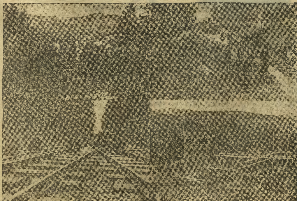
Fotomontaż przedstawia fragmenty budowy pierwszej w Polsce kolei górskiej linowo-terenowej w Krynicy. Zdjęcia przedstawiają od lewej ku prawej (na górce): rzut oka na panoramę Krynicy z torowiska kolei górskiej, fragment robót ziemnych przy budowie kolei górskiej linowo-terenowej, (u dołu) montaż mijalni kolei górskiej linowo-terenowej oraz stację górna kolei w stadium budowy.
