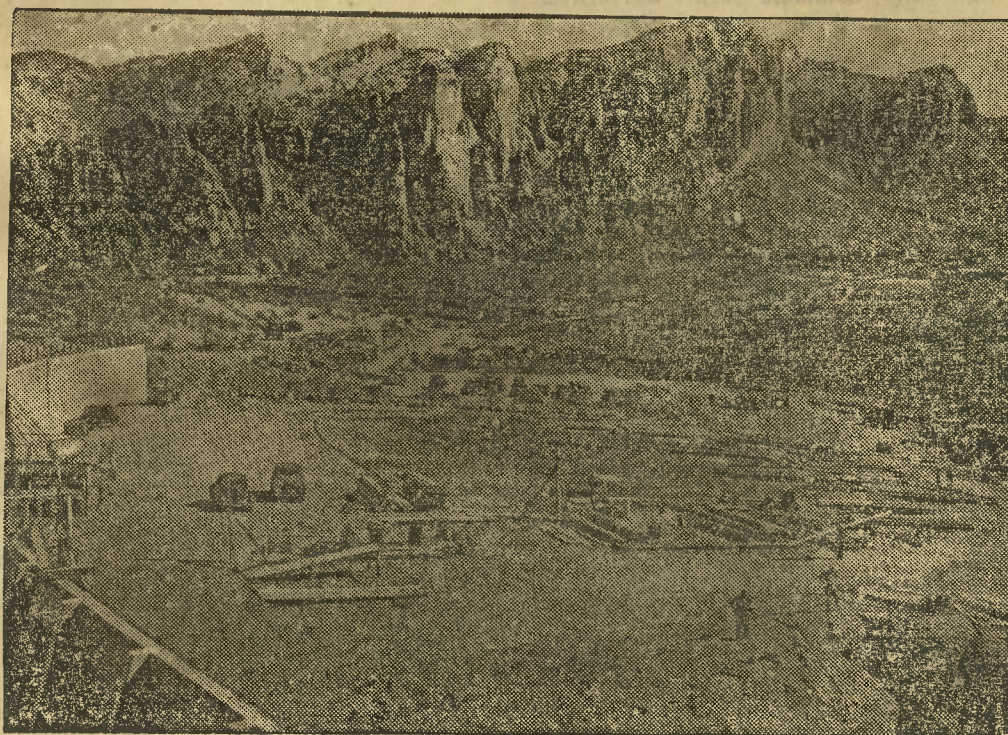
Rooseveltoska „czterolatka” celem zatrudnienia bezrobotnych obejmuje ujarzmienie górskiej rzeki Colorado. U podnóża gór Stewarta w stanie Arizona (najbardziej zaludnionym, gdyż nieurodzajnym) budują inżynierowie amerykańscy olbrzymią tamę. I stąd rozprowadzać będą wodę na suche tereny.
