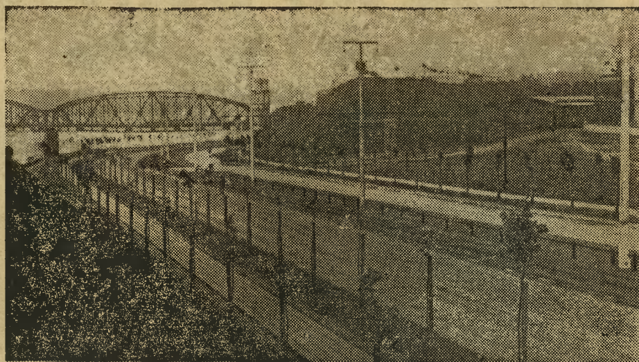
Nowa ulica — Traugutta — dwutorowa. Widok na most kolejowy. Robota ukończona w 1936 roku.
