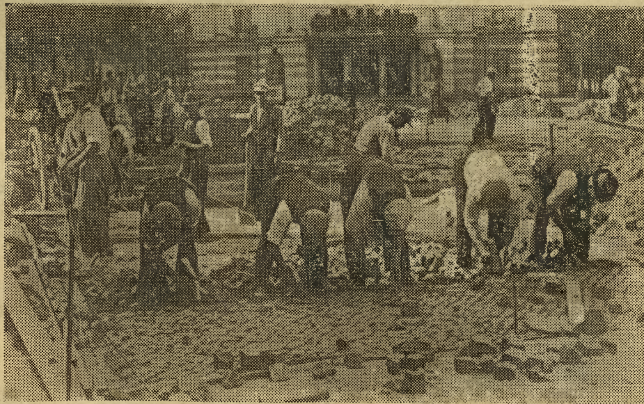
Regulacja i przebudowa placu Teatralnego. Układanie kostki bazaltowej na betonie.
