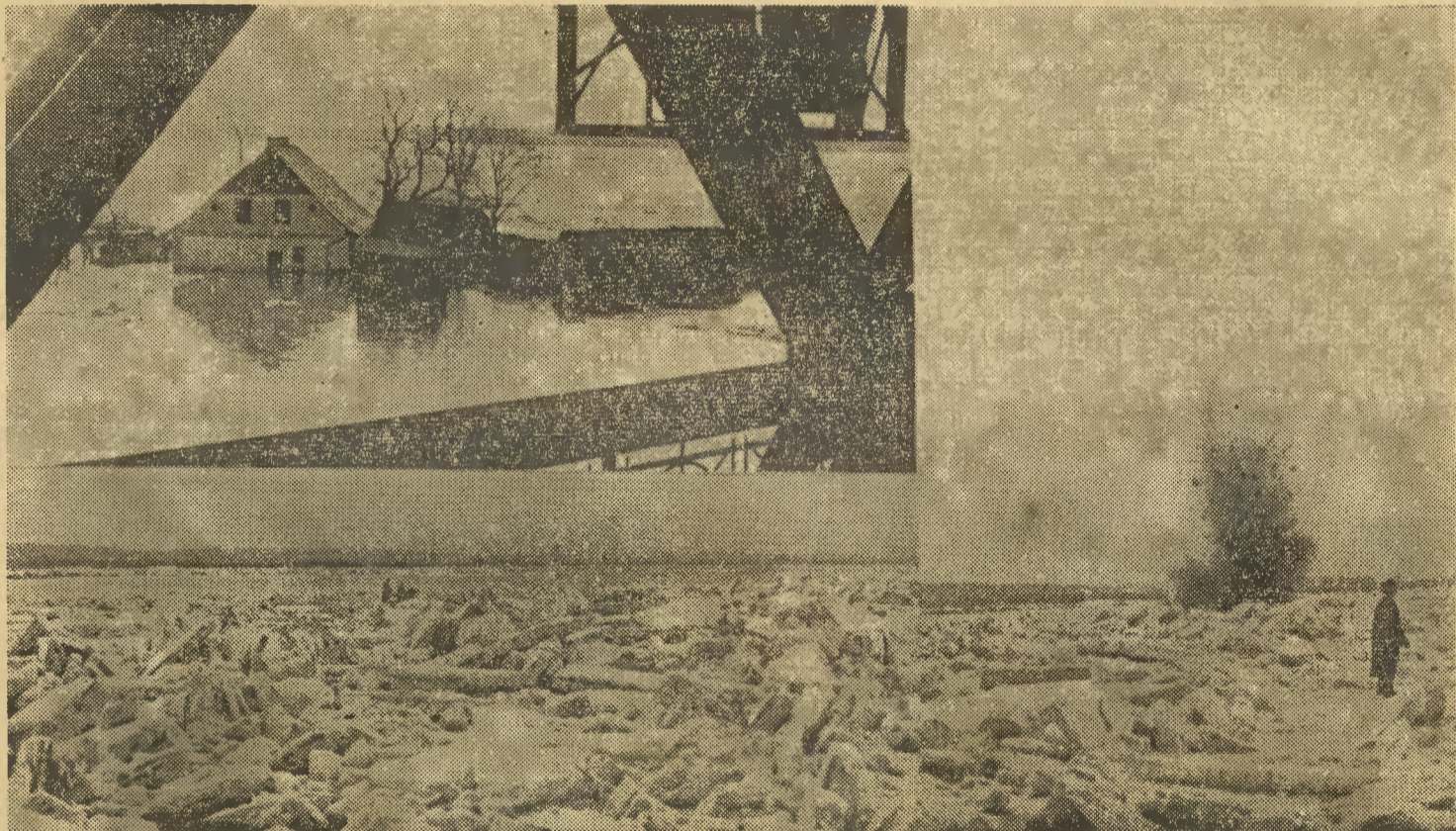
Widok z mostu fordońskiego na zalane okolice. — Zakładanie min pod zator lodowy na Wiśle i chwila wybuchu ładunku.
