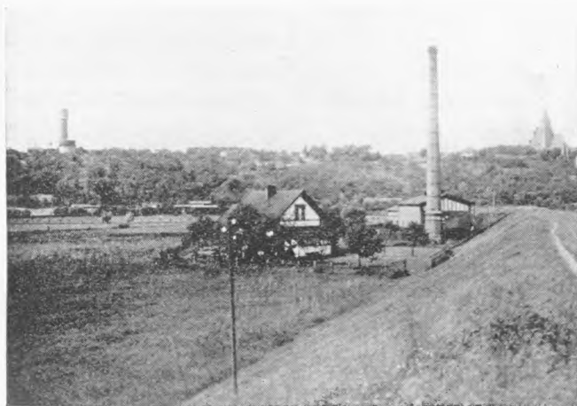
Ryc. 12. Stacja pomp Świecko-Nowskiego Związku Wałowego z widokiem na Nowe.
