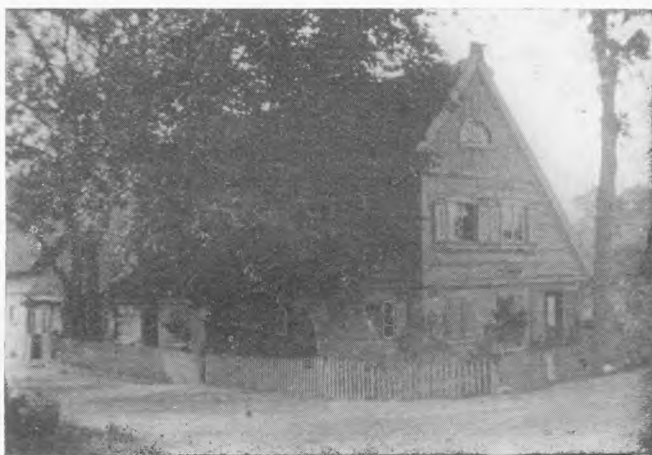
Ryc. 8. Piętrowa przybudówka dla rodziców przy starym domu holenderskim. Na strychu okienko w formie wachlarza; jest to motyw hiszpański, przyjęty przez Holendrów w ich ojczyźnie za czasów panowania Hiszpanów. Motyw ten jest tu uproszczony. Na żuławach Gdańskich są wachlarze takie jak w Holandji.
