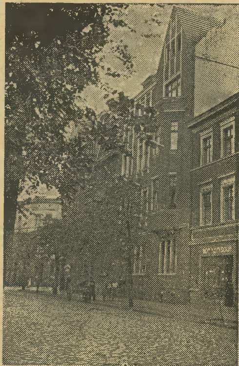
Dom przy ul. Sienkiewicza 30, który stał się wczoraj widownią tajemniczego otrucia gazem.
