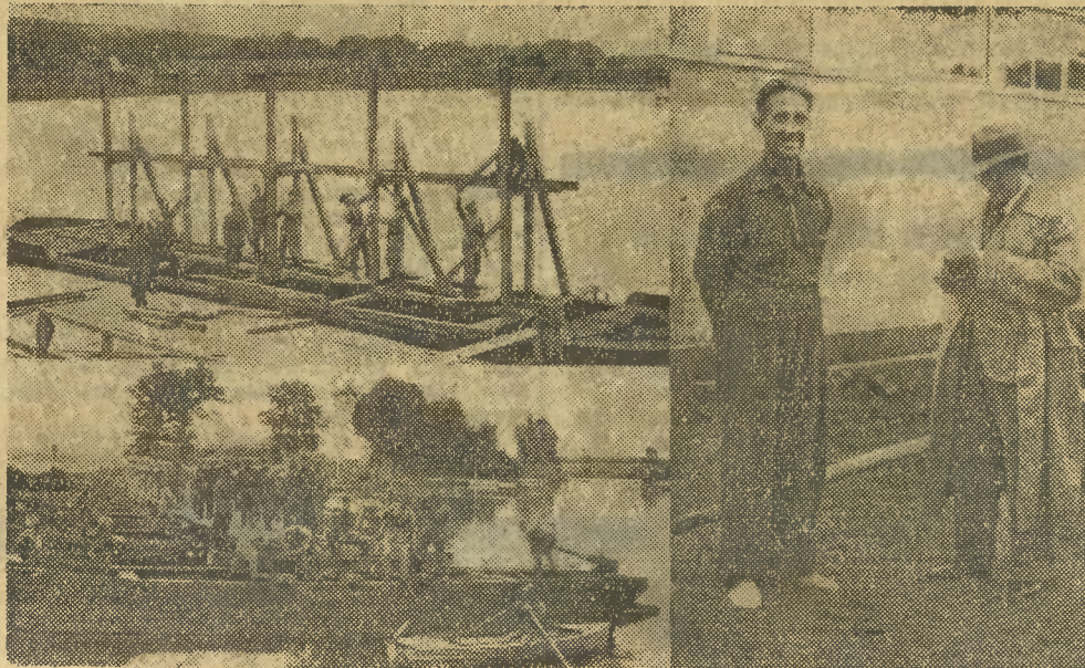
Zdjęcia nasze przedstawiają: na lewo u góry — budowa tablicy orientacyjnej, u dołu most pontonowy, łączący trybuny z szosą, już na ukończeniu. — na prawo nasz współpracownik przeprowadza wywiad z czołowym skifistą polskim — Verey'em (AZS. Kraków). Fot. J. Czarnecki.
