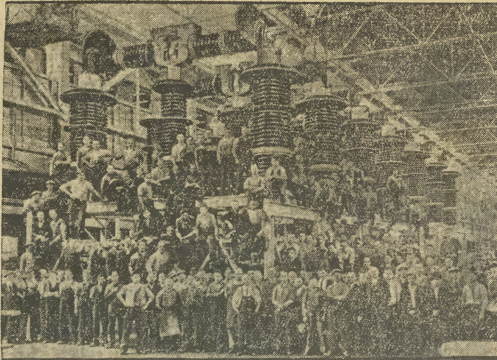
W Filadelfji zmontowano olbrzymie transformatory elektryczne, które rozmiarami nie mają równych w świecie. Transformatory zbudowała fabryka Boulderdam w Los Angeles.
