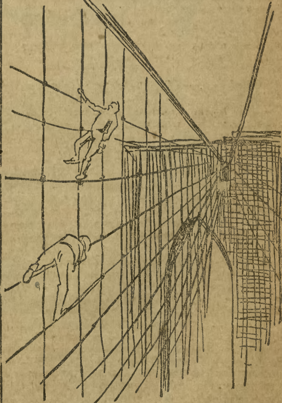
Most broklyński podobny jest ze swymi rusztowaniami do olbrzymiej sieci pajęczej. Specjalnie do jego naprawy wyszkoleni robotnicy, spinając się po jego przęzłach robią z daleka wrażenie pajaków przesuwających się po olbrzymiej pajęczej przędze.
