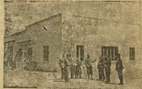
Ochronka przerobiona z obory.
