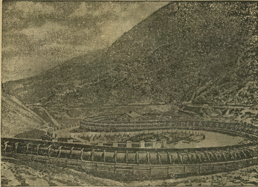
Zbudowana w latach 1868—71 kolej żelazna francusko-włoska, posiada u wylotu góry Mont Cenis — w dolinie — tor pokryty dachem blaszanym. Dach ten zabezpiecza tor kolejowy przed zasypaniem lawinami śnieżnymi.
