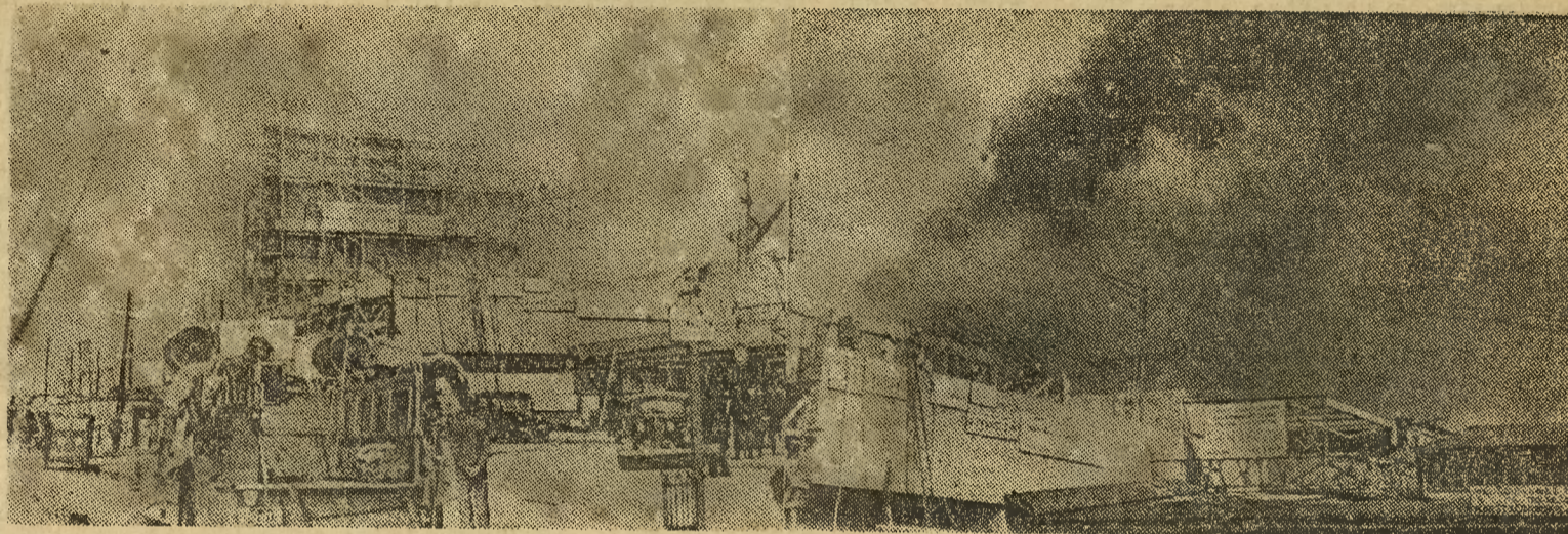
Widok gmachu dworca po akcji ratowniczej i runięciu dachu. — Widok płonącego dworca.
