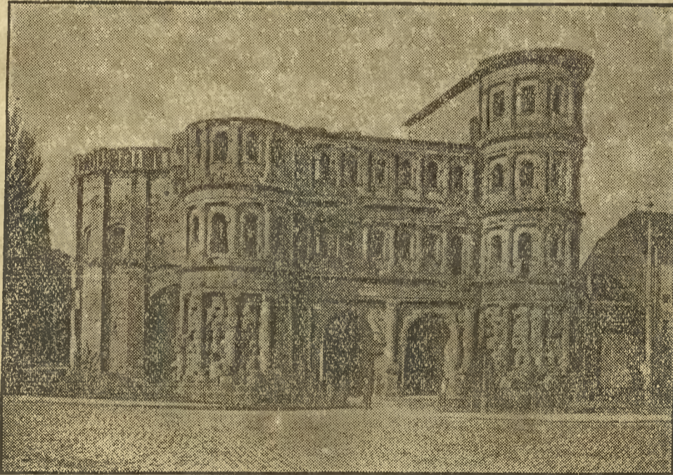
Brama Rzymska w Trewirze, słynny zabytek budownictwa rzymskiego, chyli się ku ruinie. Służy ona jako brama wjazdowa do miasta, a nieobliczona w budowie na przejazd pod nią aut ciężarowych i szybkojeżdżących samochodów, zarysowała się w fundamentach i jest bliską zawalenia się. Miasto wstrzymało narazie wszelki ruch komunikacyjny pod tą bramą.
