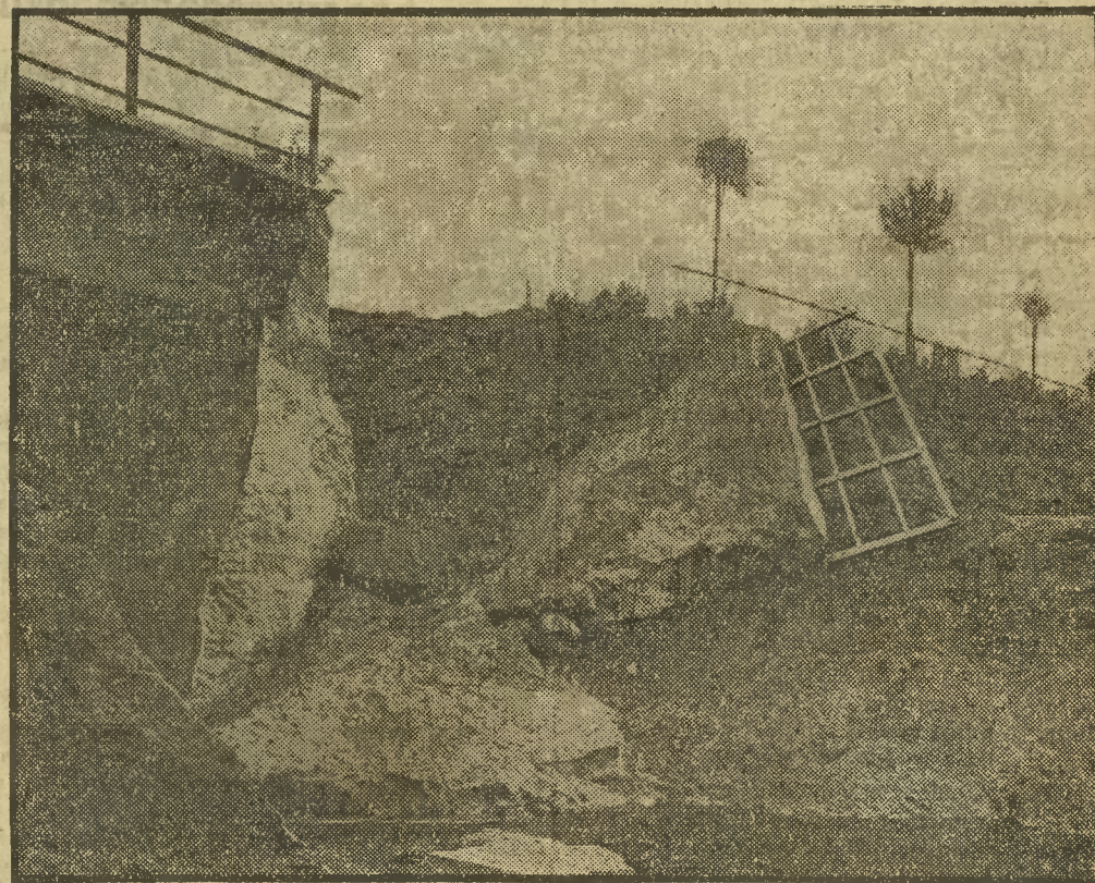
GRUZY MOSTU POD CZARNOWEM, w powiecie toruńskim, zniszczonego przez ostatnie ulewy.
