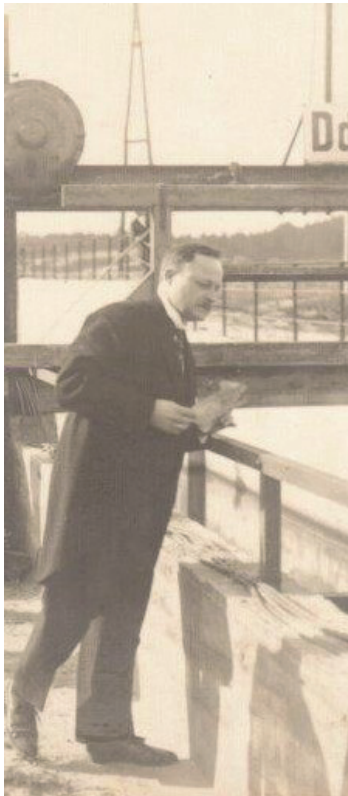
Fot. 10. Alfons Hoffmann podczas budowy elektrowni wodnej w Gródku (1922 r.) [9]
