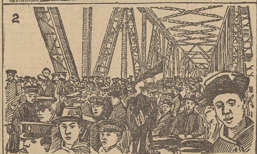
Vollendung eines deutschen Bauwerkes in China: Einweihung der 1250 Meter langen Hoangho-Brücke bei Lo Kou. 1. Vizetönig Chou (X) und Generaldirektor Hiao (XX). 2. Die Brücke während der Einweihung.
