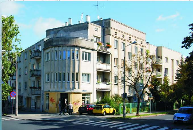
Dom Henryka i Gerharda Krausów przy ul. Słowackiego 38/40 (1936-1938) został zaprojektowany przez torunianina Bronisława Jeziołskiego. Dominantę kompozycyjną stanowi tu zaokrąglony narożnik nakryty płaskim dachem, na którym urządzono taras, ograniczony na wzdłuż mostku kapitańskiego metalową barierką. Narożnik, wyartykułowany gęstymi quasi-żebami, pomiędzy którymi znajdują się wąskie okienka, wyraźnie nawiązuje do kształtu dziobu statku. Okrętowe inspiracje projektanta potwierdza też trójkatny rzut budynku.
