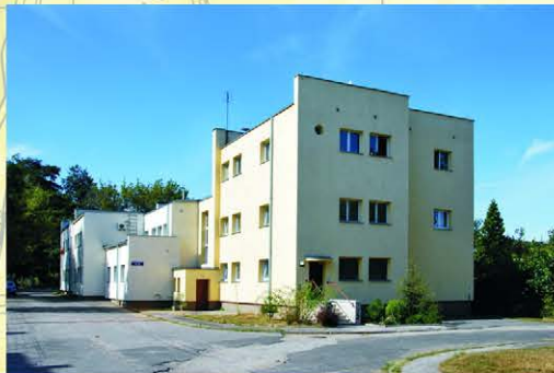
W budynku Radiostacji Pomorskiej trudno doszukać się dawnej formy i funkcji. Został adaptowany na mieszkanie, w związku z tym część kubatury nadbudowano oraz wykuto dodatkowe otwory okienne. Ponadto ocieplenie elewacji za pomocą tynku na styropianie spowodowało, że awangardowy charakter architektury uległ całkowitemu zatarciu.
