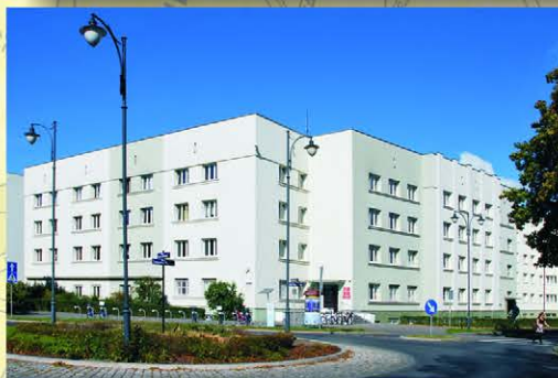
W ramach renowacji dawnego Domu Społecznego im. Józefa Piłsudskiego w 2005 roku cechy architektury funkcjonalistycznej uległy zatarciu. Biała kolorystyka budynku została zastąpiona pistacją w odmianie ciemniejszej i jaśniejsze, usunięto także charakterystyczny detal architektury awangardowej w postaci metalowej sterczyń-anteny.
