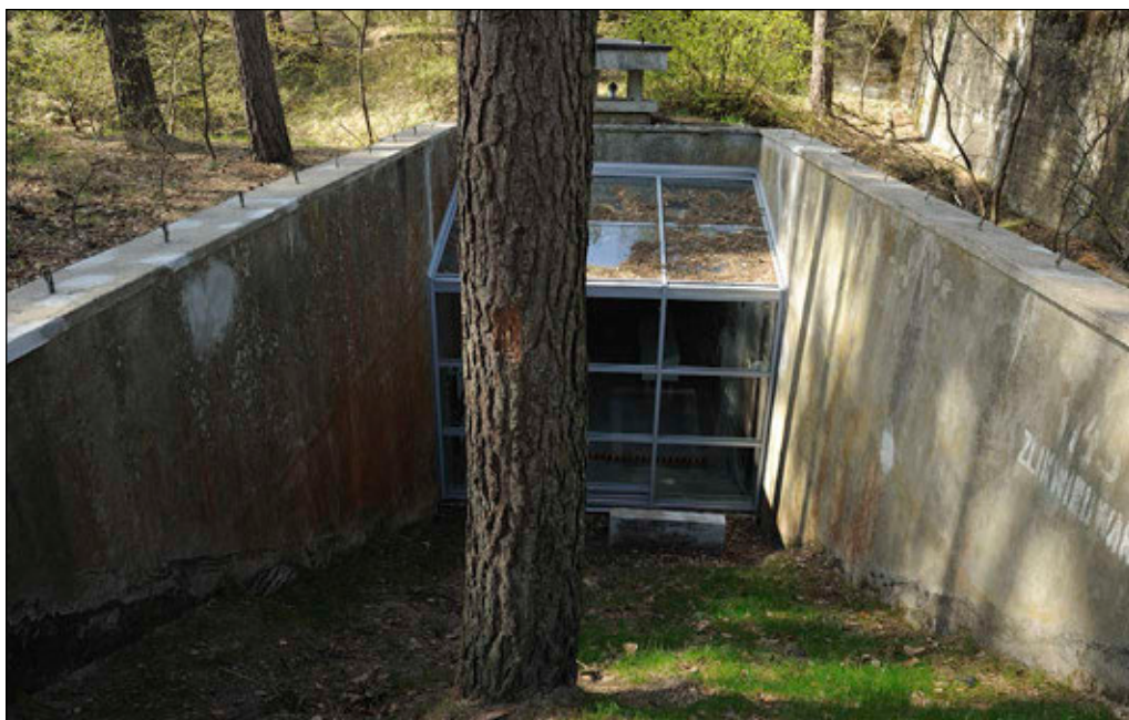
7. Budynek 1145 – Budynek płukania kwasów
