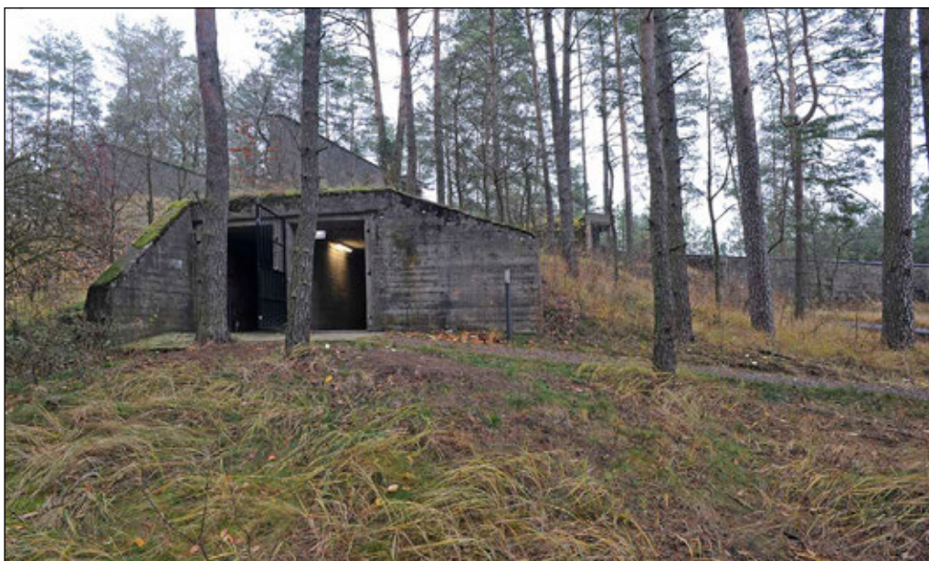
4. Budynek 1137 Budynek nitracji gliceryny
