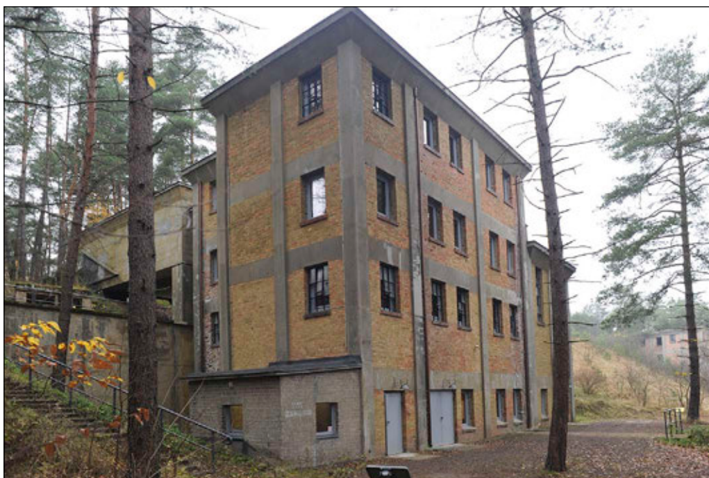
6. Budynek 1115 – Budynek denitracji kwasów
