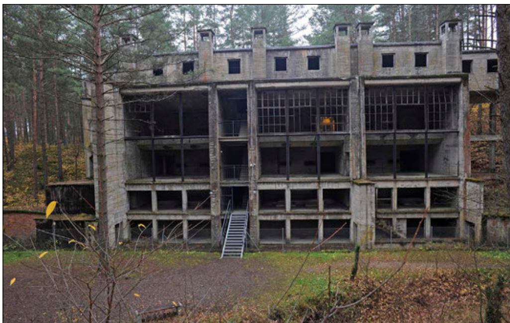
9. Budynek 1153 – Budynek żelatynizacji
