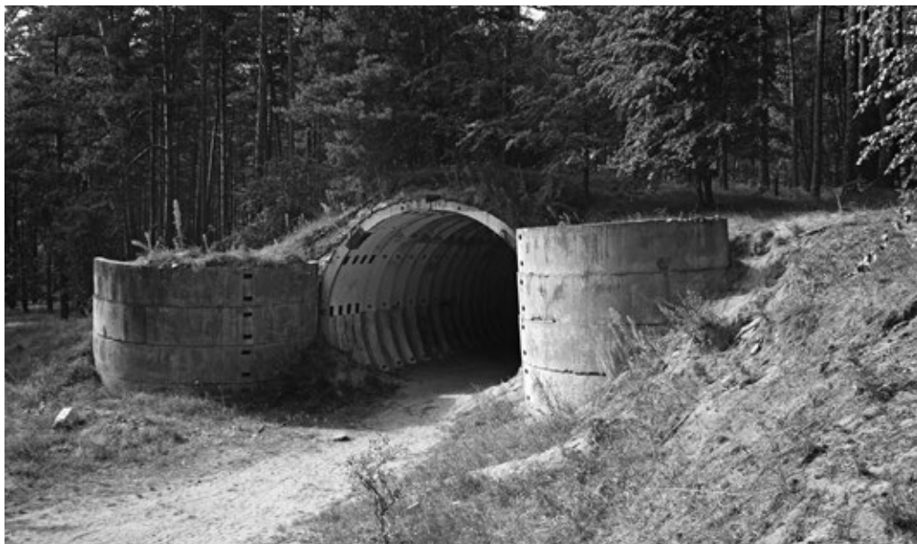
Fot. 3. Schron „Granit” na wyrzutnię rakiet, Brzeźnica Kolonia. Zdjęcie ze zbiorów Autora.
