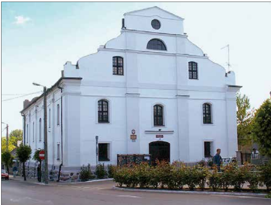
Fot. V.17. Budynek synagogi w Lubrańcu, widok obecny.
