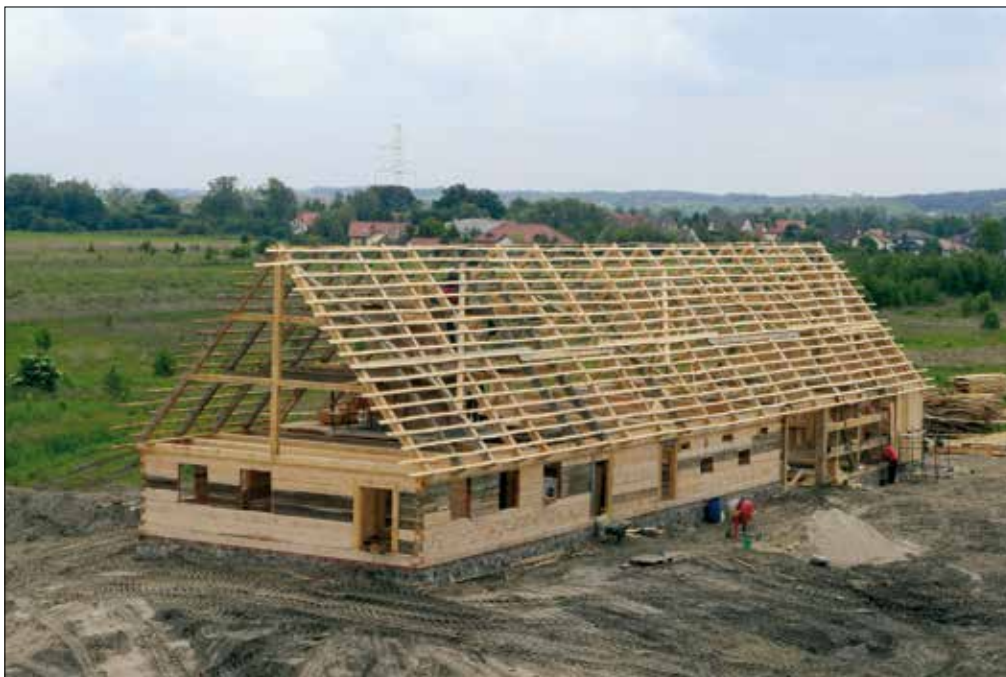
Fot. XIX.9. Zagroda z Niedźwiedzia w trakcie prac montażowych na terenie Ołędzkiego Parku Etnograficznego w Wielkiej Nieszawce, 2014 r.
