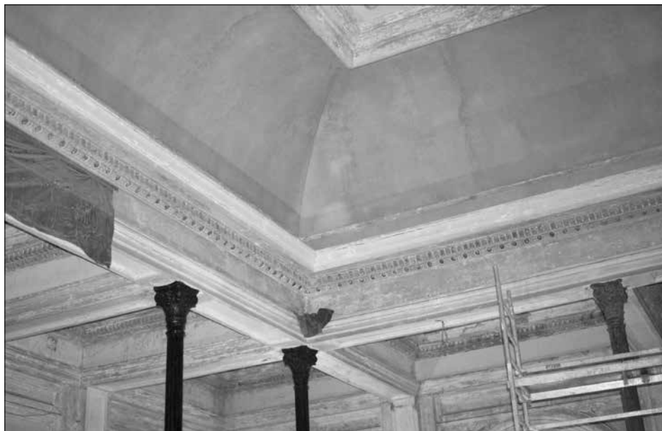
Fot. XV.11. Sala restauracyjna dla pasażerów II klasy dworca kolejowego w Aleksandrowie Kujawskim w trakcie prac konserwatorskich.
