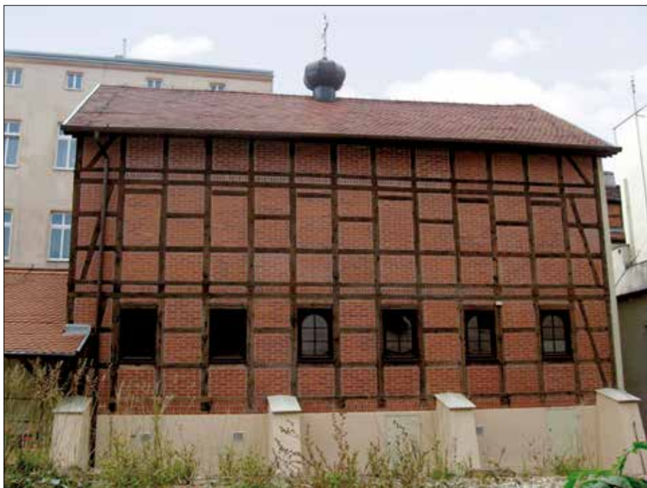
Fot. XII.2. Widok kościoła prawosławnego pw. św. Mikołaja w Bydgoszczy.
