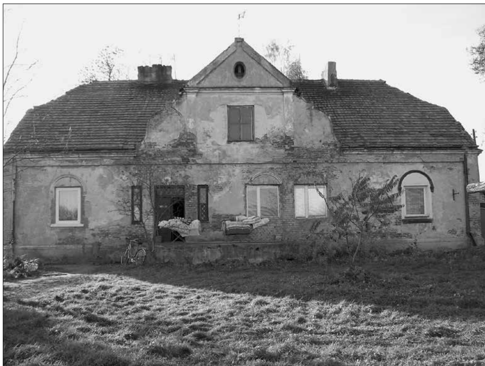
Fot. VII.2. Ignalin – dwór, elewacja frontowa od wschodu, 2010 r.
