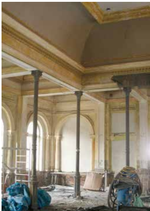
Fot. XV.24. Sala restauracyjna dla pasażerów II klasy dworca kolejowego w Aleksandrowie Kujawskim w trakcie prac konserwatorskich.
