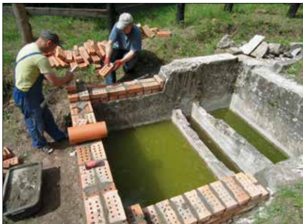
Fot. X.18. Prace rekonstrukcyjne – kopalnia „Montania”, 2011 r.
