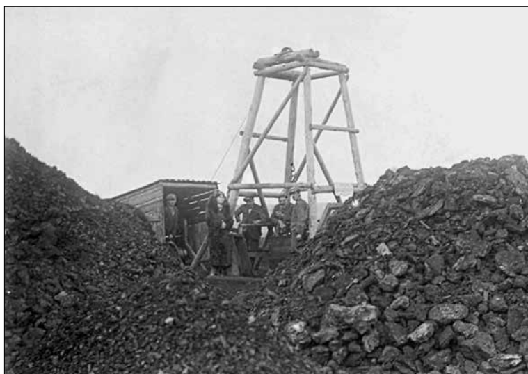
Fot. X.11. Szyb pionowy – kopalnia „Teresa” – 1937 r. Na pierwszym planie widoczne 3 gatunki węgla.
