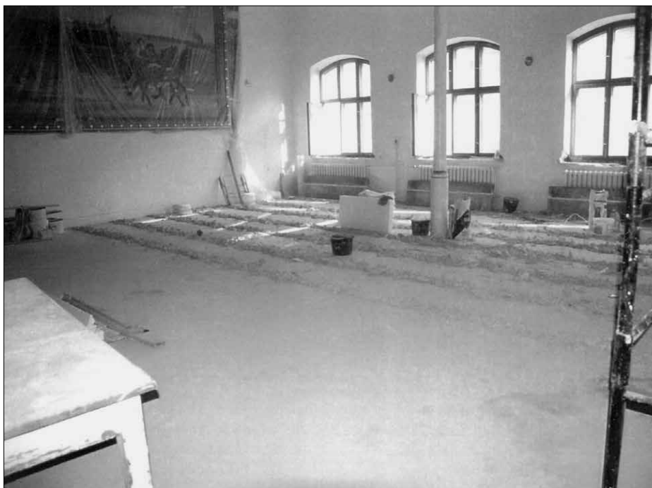
Fot. XV.8. Sala Zebrań w dawnej remizie Ochotniczej Straży Ogniowej we Włocławku. W trakcie prac remontowych, konserwatorskich i restauratorskich.
