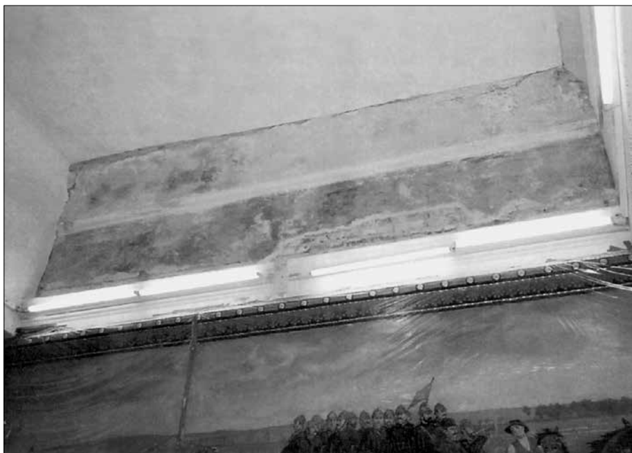
Fot. XV.6. Sala Zebrań w dawnej remizie Ochotniczej Straży Ogniowej we Włocławku. Odkrywki oryginalnej dekoracji ścian nad malowidłem.
