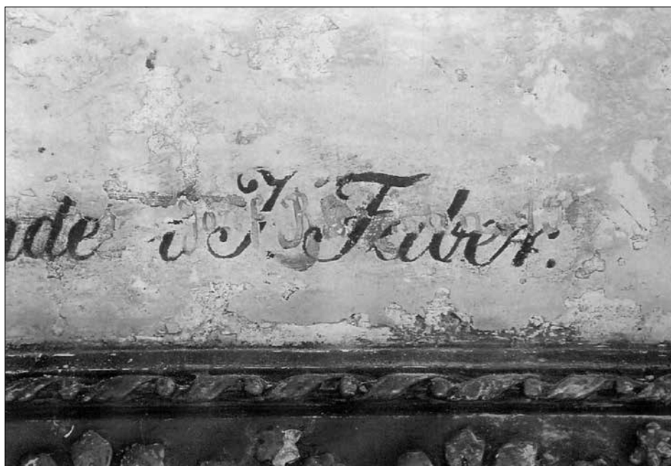
Fot. XV.5. Sala Zebrań w dawnej remizie Ochotniczej Straży Ogniowej we Włocławku. Malowidło „Wyjazd do pożaru” – fragment malowidła w trakcie oczyszczania – warstwy wtórne z konserwacji z 1937 r.
