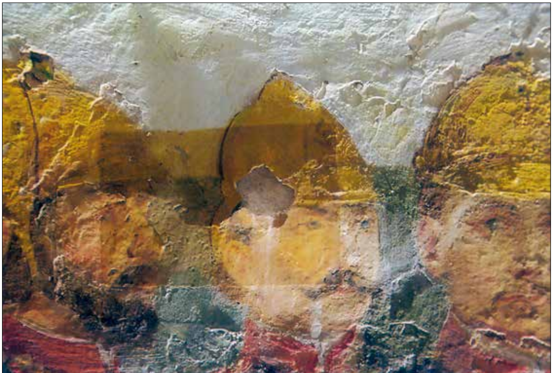
Fot. XV.20. Sala Zebrań w dawnej remizie Ochotniczej Straży Ogniowej we Włocławku. Malowidło „Wjazd do pożaru” – fragment malowidła w trakcie oczyszczenia – widoczne zniszczenia warstwy malarskiej.
