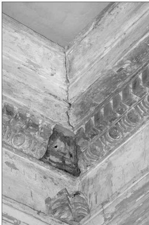
Fot. XV.10. Sala restauracyjna dla pasażerów II klasy dworca kolejowego w Aleksandrowie Kujawskim w trakcie prac konserwatorskich – fragment sztukaterii po zdjęciu warstw wtórnych.
