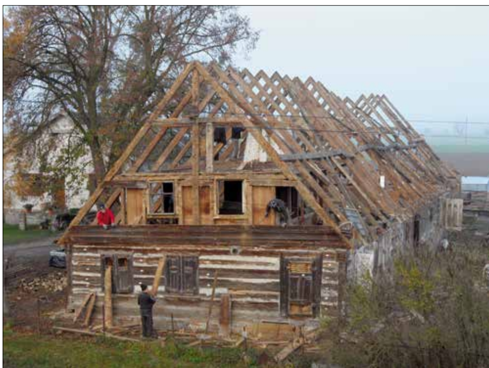
Fot. XIX.8. Zagroda w Niedźwiedziu w trakcie prac rozbiórkowych, 2013 r.
