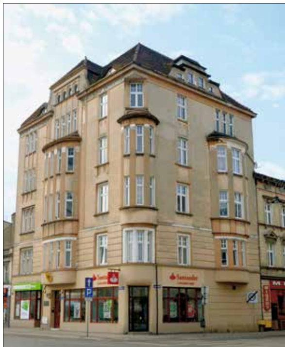
Fot. XIII.12. Kamienica przy ul. Śniadeckich 49 u zbiegu z ul. Matejki (proj. Alfred Schleusener, l. 1911–1912).
