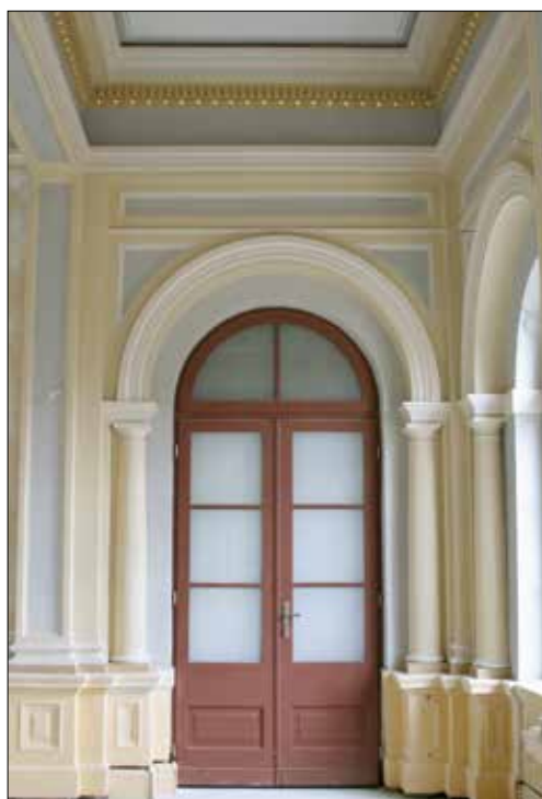
Fot. XV.25. Sala restauracyjna dla pasażerów II klasy dworca kolejowego w Aleksandrowie Kujawskim w trakcie prac konserwatorskich – odrestaurowany fragment wnętrza.
