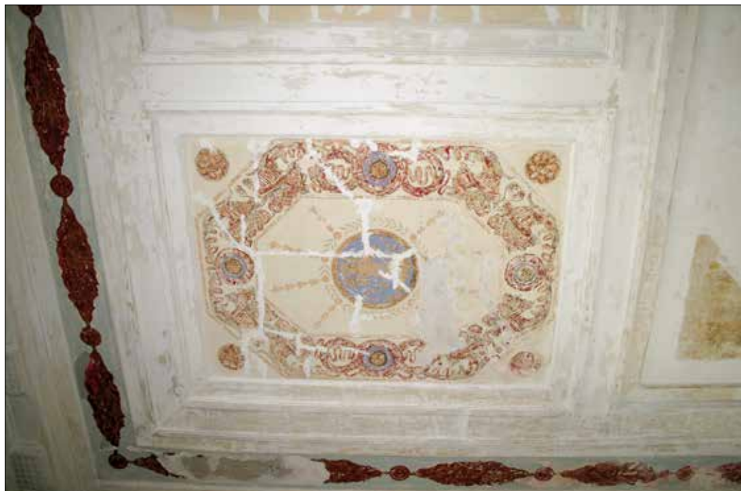
Fot. XV.14. Pałac Biskupi we Wrocławku. Jadalnia w trakcie prac konserwatorsko-restauratorskich. Konserwacja malowideł.
