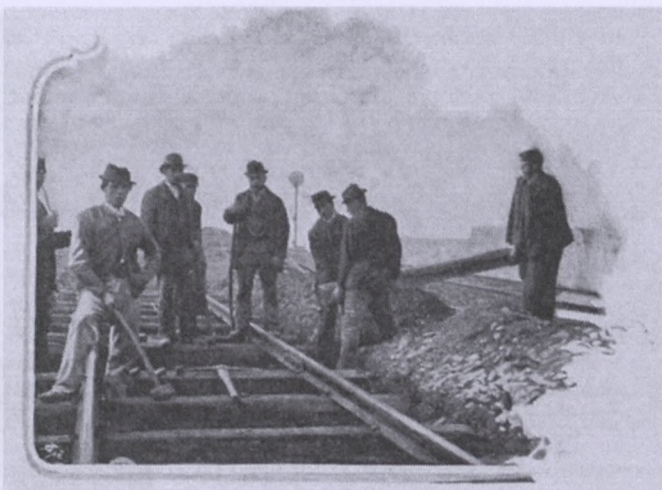
11. Budowa pierwszej drogi żelaznej łączącej Wiedeń z Bochnią
