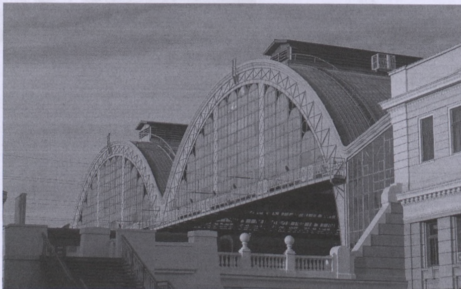
68. Lwów, Dworzec Kolei Karola Ludwika. Konstrukcja czoła hali peronowej, gdzie pierwotnie znajdowały się herby Austro-Węgier
