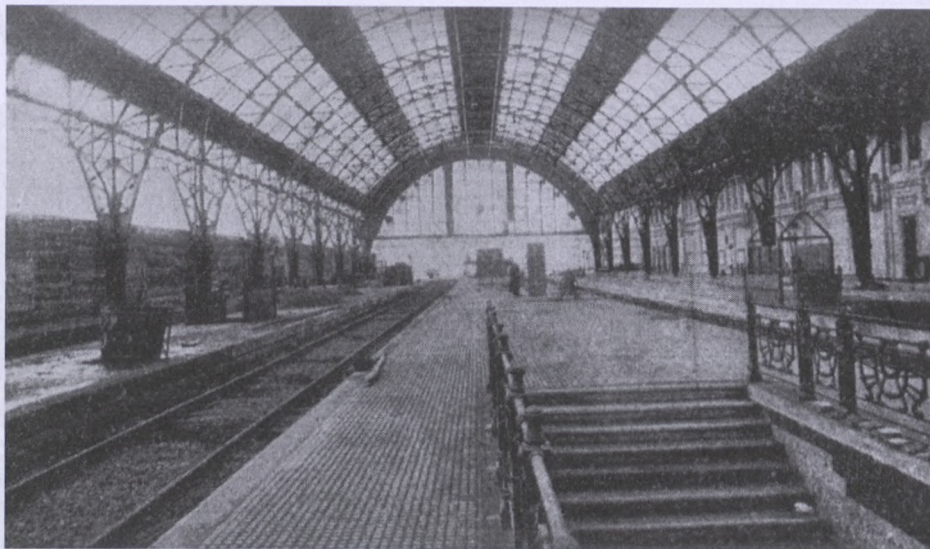
67. Hala peronowa (wnętrze)
