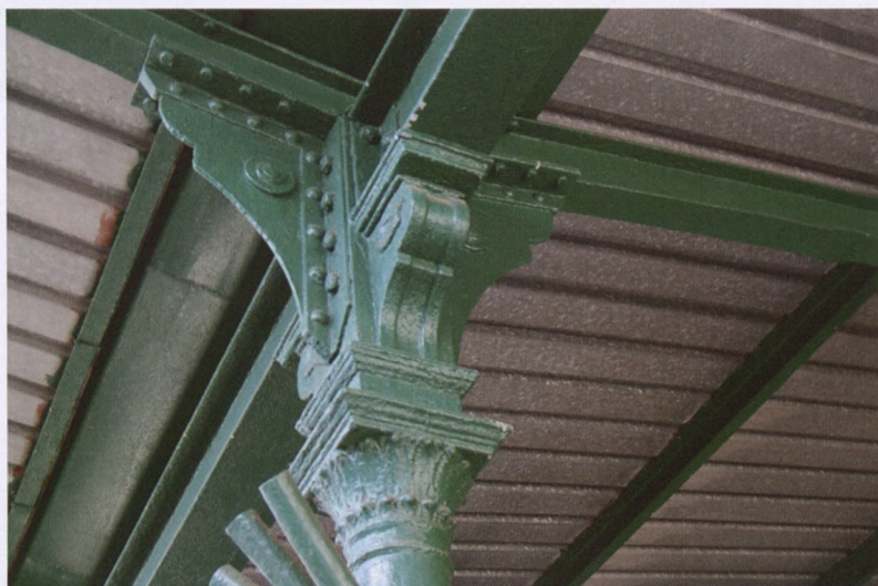
XXX. Tarnów, dworzec kolejowy, żeliwne kolumny wiaty peronowej
