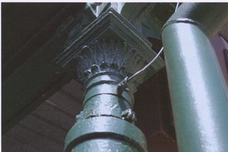
XXIX. Tarnów, dworzec kolejowy, żeliwne kolumny wiaty peronowej
