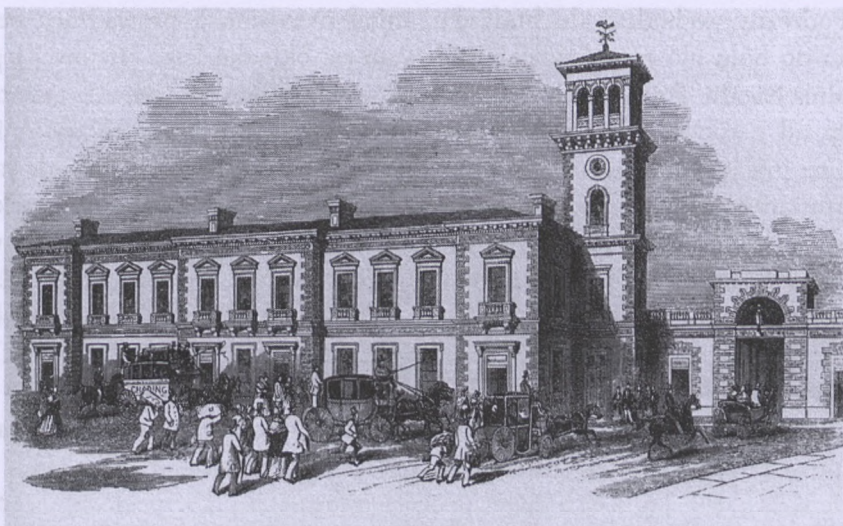
37. Formy architektoniczne wykorzystywane w budownictwie kolejowym, nawiązujące do renesansowych i barokowych pałaców; Londyn, dworzec London Bridge
