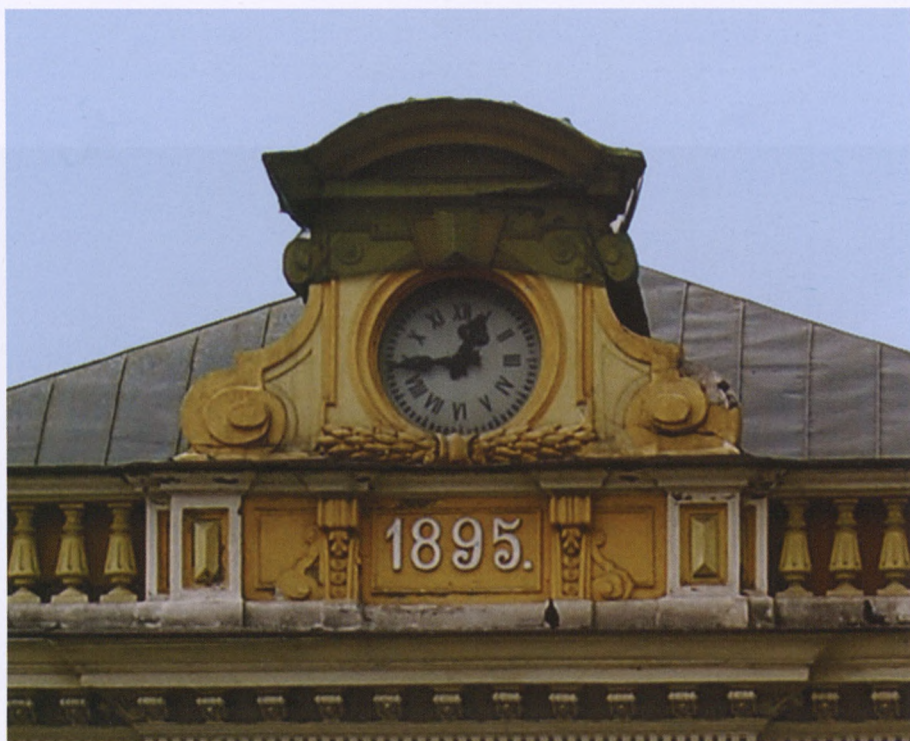
XLII. Przemyśl, dworzec kolejowy, zegar wieżowy w zwieńczeniu elewacji frontowej pawilonu głównego
