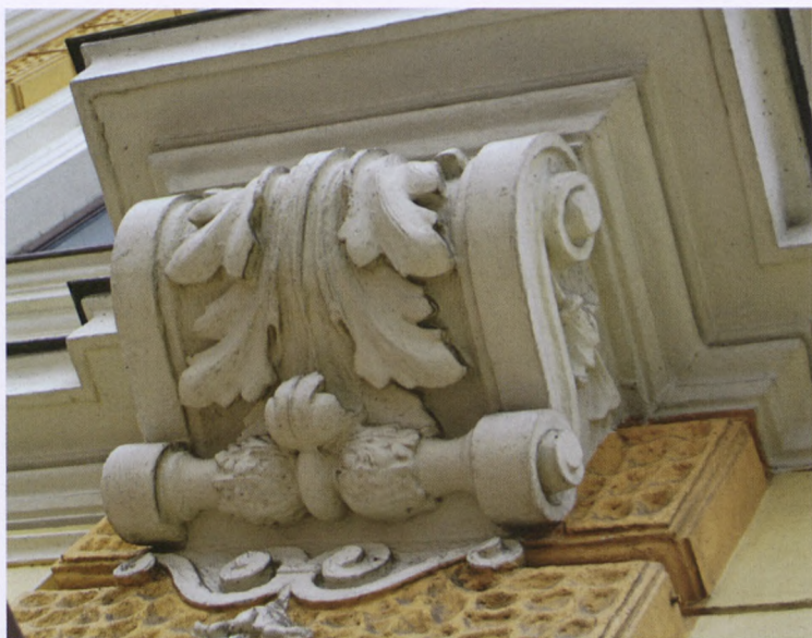
XXXIX. Przemysł, dworzec kolejowy, konsola dekorowana liściem akantu na wolutowym spływie w fasadzie pawilonu głównego
