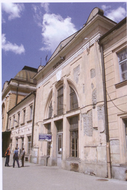
XXVII. Tarnów, dworzec kolejowy, elewacja skrzydeł bocznych
