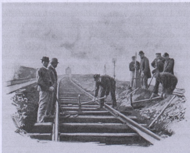
10. Budowa pierwszej drogi żelaznej łączącej Wiedeń z Bochnią
