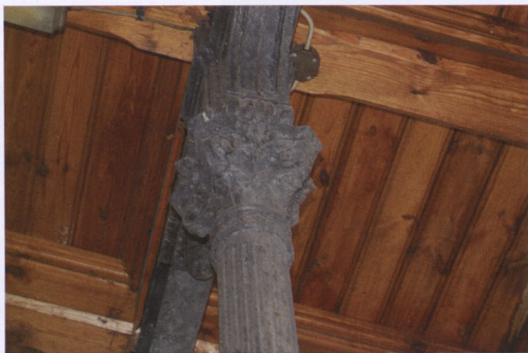
XLVI. Przemyśl, dworzec kolejowy, wiata peronowa
