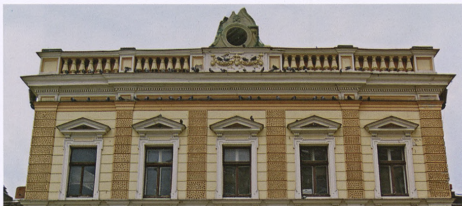
XLII. Przemyśl, dworzec kolejowy, fragment elewacji frontowej pawilonu bocznego z attyką w formie balustrady z centralnie umieszczoną girlandą, zwieńczoną facją
