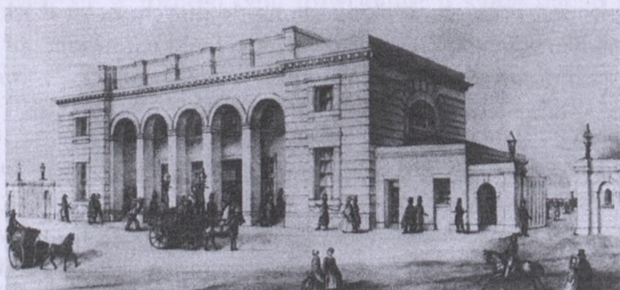
35. Formy architektoniczne wykorzystywane w budownictwie kolejowym, nawiązujące do rzymskich term; Londyn, dworzec Nine Elms
