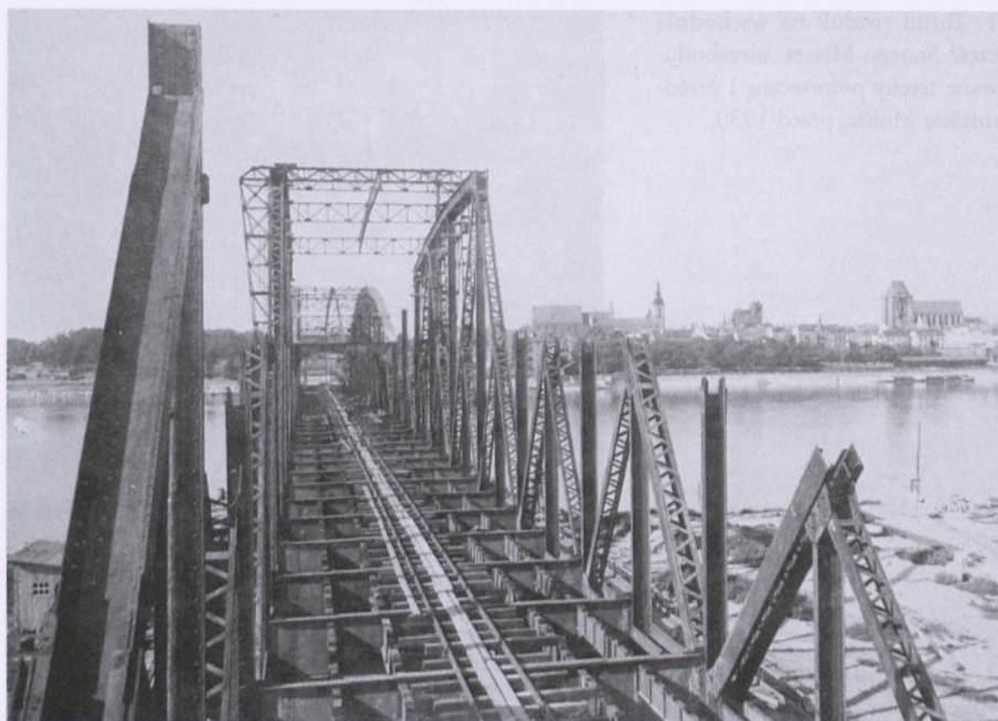
3. Toruń, budowa mostu drogowego, przed 1934.
