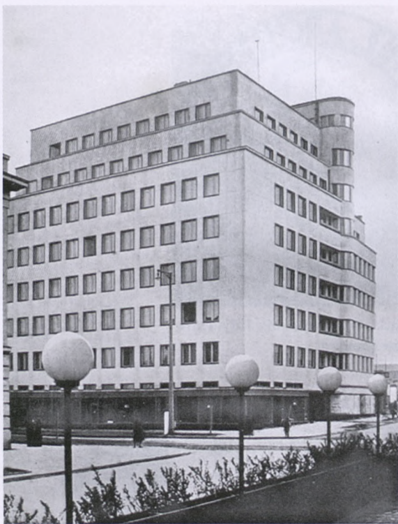
59. Gdynia, budynek biurowo-mieszkalny Banku Gospodarstwa Krajowego, zaprojektowany przez Stanisława Ziółowskiego, zrealizowany 1935–1937.
