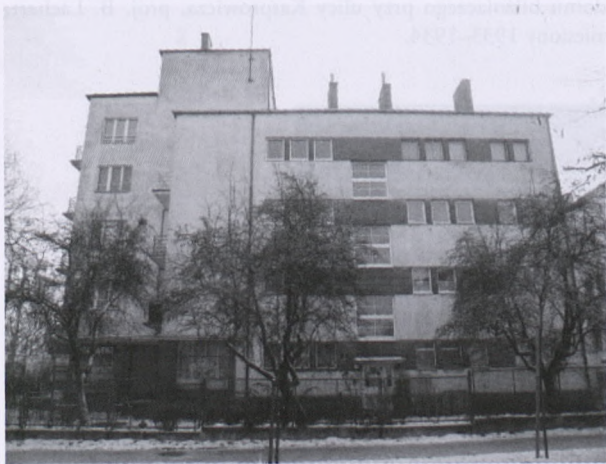
37. Toruń, budynek mieszkalny Towarzystwa Ubezpieczeń Wzajemnych Vesta z Poznania, przy ul. Mickiewicza, proj. W. i K. Sylwestrowiczowie, 1934, stan z 2005.
