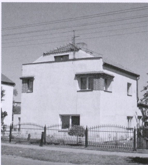
44. Grudziądz, dom wzniesiony przez Pomorskie Zakłady Ceramiczne 1933/34, stan obecny.
