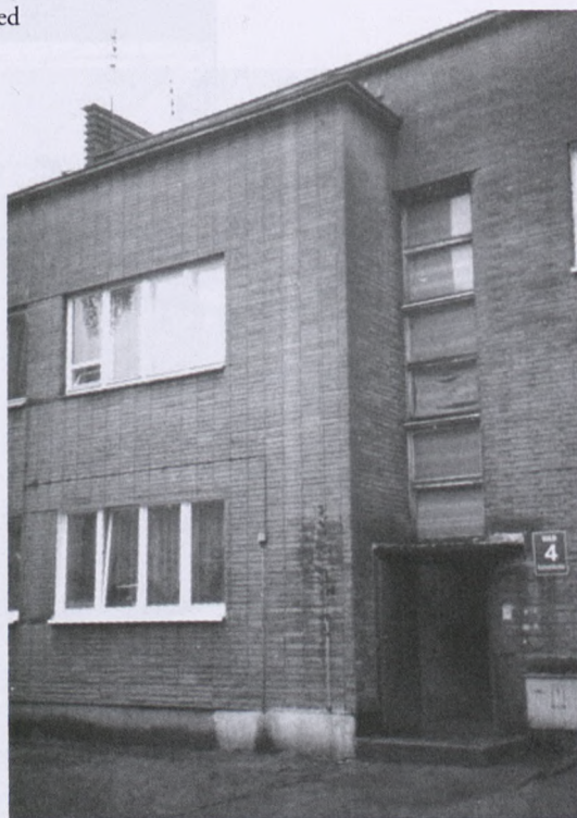
56. Hel, fragment domu osiedla ofi- cerskiego.
