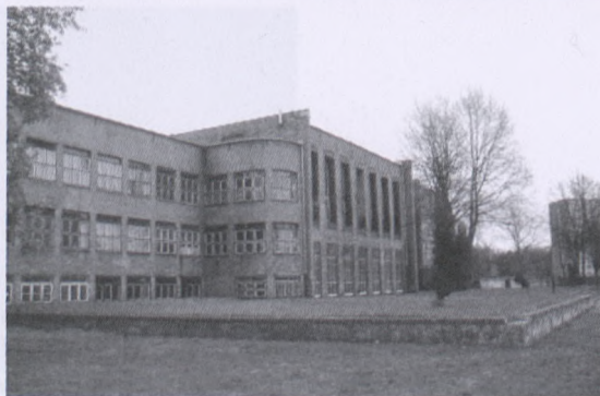
45. Grudziądz, Gimnazjum Mniejszości Niemieckiej tzw. Goetheschule przy ulicy Herzfelda, wzniesione 1930–1932 wg projektu A. Krügera, u góry: widok elewacji frontowej i wschodniego skrzydła, u dołu: widok od strony boiska.
