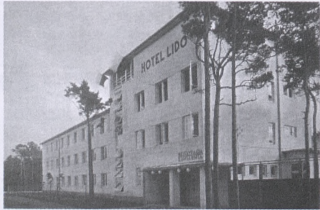
53. Jurata, Hotel Lido zaprojektowany przez J. i J. Poznańskich, wzniesiony 1932–1934, stan w okresie międzywojennym.
