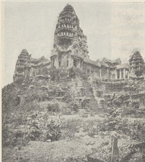
Fig. 20. Angkor-Vat. — Dieser Tempel wurde im 12. Jahrhundert erbaut.
