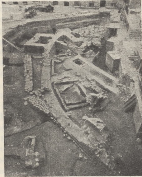
Fig. 154. Überreste von Absalons Burg und dem Schloß Kopenhagen, die jetzt unter dem Schloß Christiansborg liegen. A. Ringmauer, B. Turm, C. Ziegelmauer, D. Außenmauer, E. Backofen, F. Rittersaal aus dem 15. Jahrhundert.
