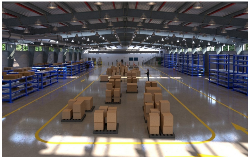
Rys. 19. Wnętrze budynku – część produkcyjno-magazynowa
