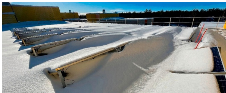
Rys. 4. Zjawisko tworzenia się zasp śnieżnych w sąsiedztwie paneli
